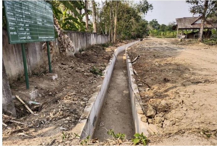
โครงการก่อสร้างคลองส่งน้ำ (ศาลาประชาคม-บ้านนายเจริญ แก้วรากมุก ) บ้านสันสลี หมู่ ๔
