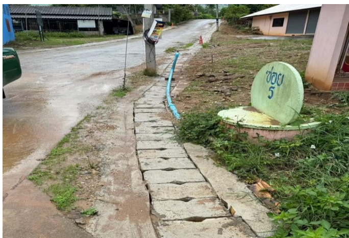
โครงการก่อสร้างรางระบายน้ำข้างถนน (ซอย ๕ ศาลาประชาคมหมู่บ้าน) บ้านแม่มะ หมู่ ๑
