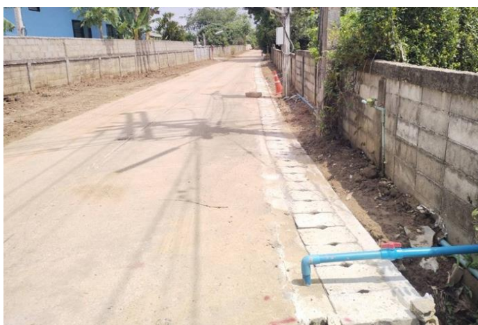
โครงการก่อสร้างรางระบายน้ำ (ซอย ๒) บ้านศรีบุญยืน หมู่ ๑๐
