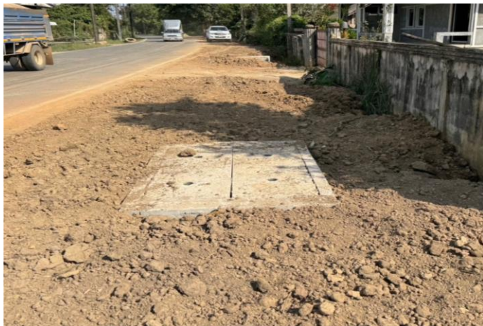
โครงการวางท่อพร้อมบ่อพัก (จากห้าแยกถึงลำเหมืองป่าถ่อน) บ้านด้าย หมู่ ๓
