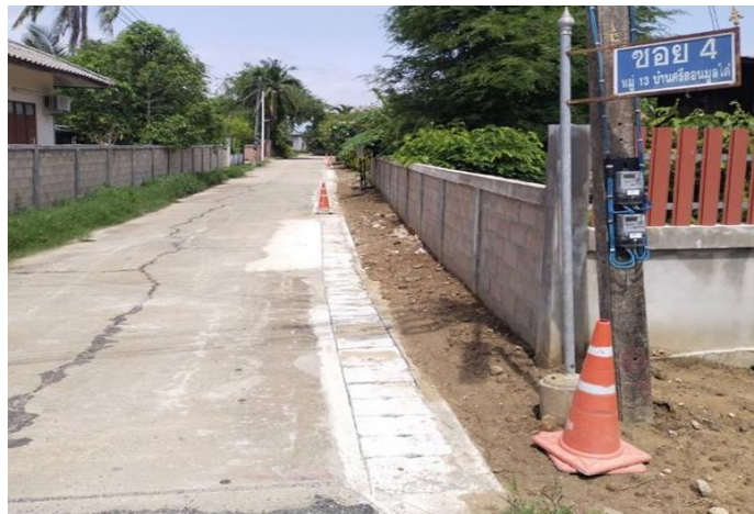
โครงการก่อสร้างวางระบายน้ำข้างถนน (ซอย ๔) บ้านศรีดอนมูลใต้ หมู่ ๑๓
