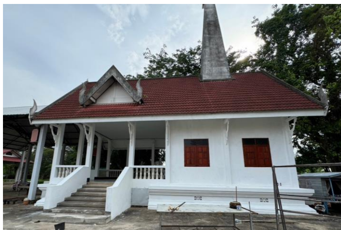
โครงการปรับปรุงเมรุ บ้านศรีดอนมูล หมู่ ๙
