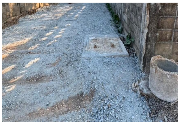
โครงการวางท่อระบายน้ำข้างถนน (เส้นหลัง รพ.สต.ศรีดอนมูล) บ้านศรีดอนมูลใต้ หมู่ ๑๓
