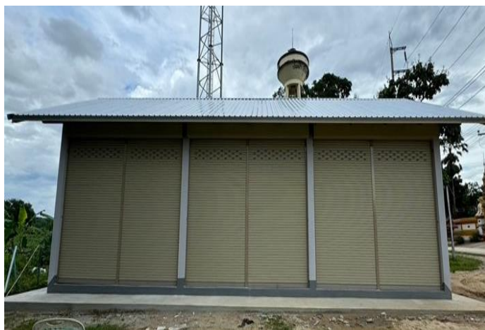
โครงการก่อสร้างศาลาเอนกประสงค์หมู่บ้าน บ้านหนองปลาสะเด็ด หมู่ ๘
