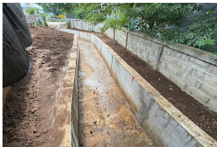
โครงการก่อสร้างคลองส่งน้ำ (จากลำห้วยจี่เฒ่าเชื่อมรางระบายน้ำข้างถนนทางหลวงชนบท) บ้านจี่เฒ่า หมู่ ๖
