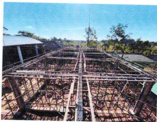
โครงการก่อสร้างอาคารสำนักงาน(อาคารห้องประชุมเอนกประสงค์)
