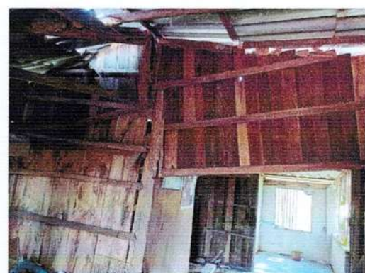
ลงพื้นที่ตรวจสอบกรณีมีผู้โพสเฟสบุ๊ค ได้แจ้งเรื่องผ่านกลุ่มต่างๆ เรื่องทุกข์ชาวบ้านจากพายุตรวจสอบพบว่าบ้านหลังดังกล่าวชำรุดทรุดโทรมเนื่องจากถูกปลวกกัดกินโครงสร้างของตัวบ้านทั้งหลังไม่เป็นไปตามหลักเกณฑ์การให้ความช่วยเหลือผู้ประสบภัยพิบัติ
