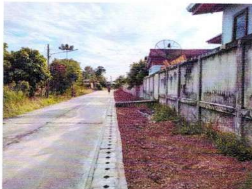
โครงการก่อสร้างรางระบายน้ำข้างถนน บ้านศรีดอนมูล หมู่ที่ ๑๓
