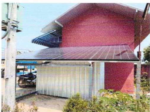
โครงการก่อสร้างระบบสูบน้ำด้วยพลังงานพร้อมถังเก็บน้ำเพื่อใช้ในการอุปโภคและบริโภค บ้านศรีดอนมูล หมู่ที่ ๑๒
