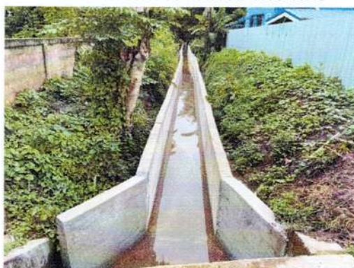
โครงการก่อสร้างคลองส่งน้ำแบบคอนกรีตตัวยูเพื่อใช้ในการเกษตร บ้านสันตันธง หมู่ที่ ๒ จุดที่ ๑
