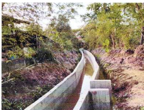
โครงการก่อสร้างคลองส่งน้ำแบบคอนกรีตตัวยูเพื่อใช้ในการเกษตร บ้านสันตันธง หมู่ที่ ๒ จุดที่ ๒
