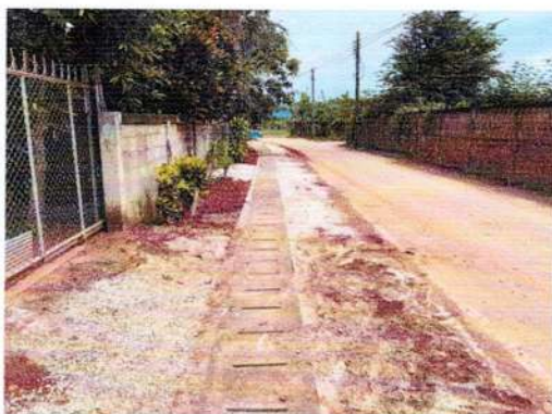
โครงการก่อสร้างรางระบายน้ำ บ้านเวียง หมู่ที่ ๕
