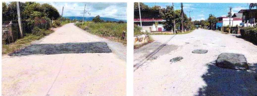
โครงการซ่อมแซมถนนภายในตำบลศรีดอนมูล
