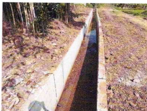
โครงการก่อสร้างคลองส่งน้ำแบบคอนกรีตด้วยเพื่อใช้ในการเกษตร บ้านปากอ้อย หมู่ที่ ๑๑
