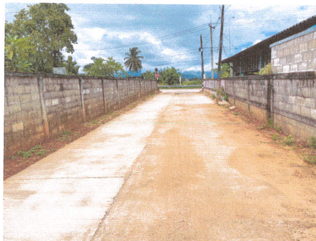
โครงการปรับปรุงต่อเติมถนนคอนกรีตเสริมเหล็ก (ซอย ๔) บ้านด้าย หมู่ ๓
