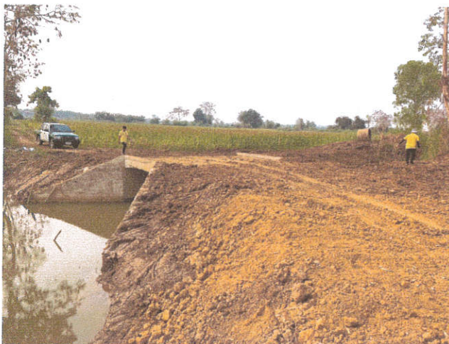
โครงการก่อสร้างท่อเหลี่ยมลำเหมืองใหม่ (บริเวณหนองแซะ) บ้านสันตันธง หมู่ ๒
