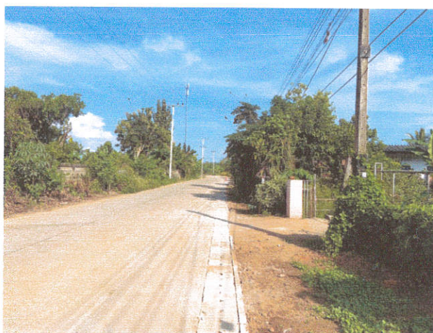
โครงการก่อสร้างรางระบายน้ำข้างถนน (ซอย ๘) บ้านศรีบุญยืน หมู่ ๑๐
