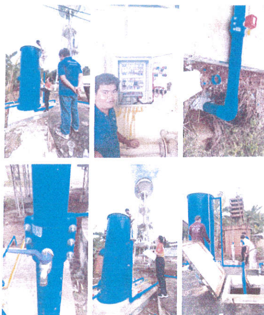
โครงการปรับปรุงระบบประปาหมู่บ้าน บ้านสันสลี หมู่ ๔
