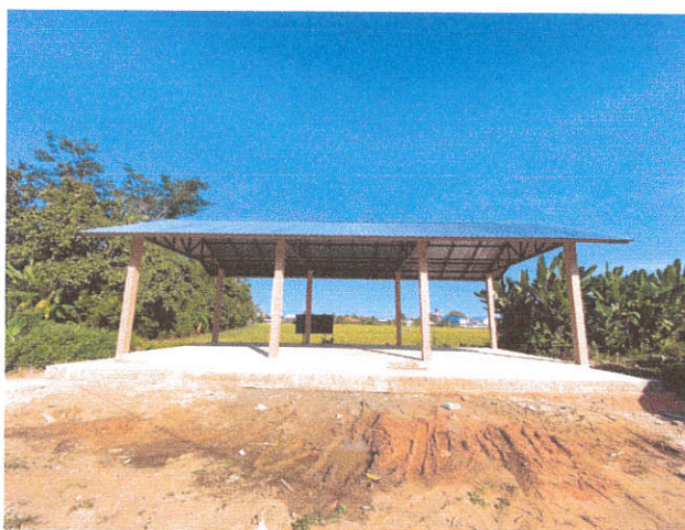
โครงการก่อสร้างโรงเรือนคัดแยกขยะ บ้านศรีดอนมูล หมู่ ๙
