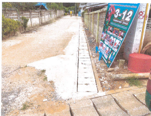
โครงการก่อสร้างรางระบายน้ำข้างถนน (ซอย ๑) บ้านเวียงแก้ว หมู่ ๕
