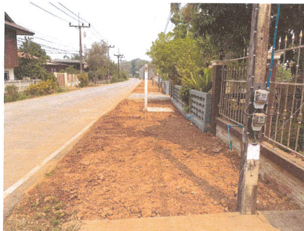
โครงการวางท่อพร้อมบ่อพัก (เส้นห้าแยกถึงลำเหมืองป่าถ่อน) บ้านด้าย หมู่ ๓
